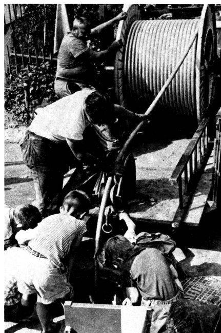
Verlegung eines Koaxialkabels — Posa di un cavo coassiale
