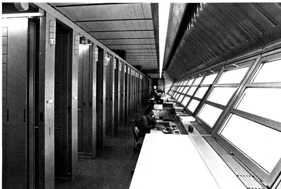
Die interkontinentale Zentrale ist die erste mit dezentralisierter Microcomputersteuerung
