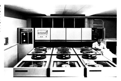
über das Datensichtgerät, vorgenommen. Dazu stehen ausser dem Computerterminal eine Schreibmaschine mit Lochstreifenstanzer oder eine optische Lesemaschine zur Verfügung. Sie arbeitet nach dem Prinzip der optischen Zeichenerkennung (OCR) und ist in der Lage, in der Minute etwa zwei mit einem besonderen Kugelkopf geschriebene A4-Manuskriptseiten zu lesen und entweder auf Lochstreifen zu stanzen oder direkt in die Computeranlage einzugeben.
