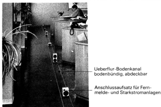
Fig. 10 Abdeckbares Überflur-Bodenkanalsystem (Beispiel einer Kanalkonstruktion mit Al-Profilen)
