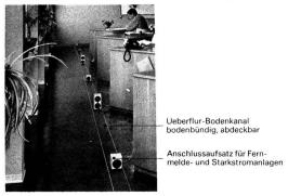
Fig. 10 Abdeckbares Überflur-Bodenkanalsystem (Beispiel einer Kanalkonstruktion mit Al-Profilen)
