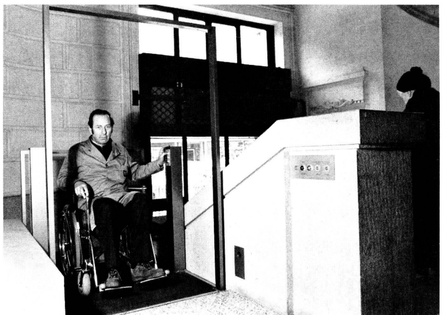
Fig. 2 Obere Haltestelle der Hebebühne
