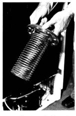
Heizflansch für den Gefrierschrank als Warmwasserbereiter, der in einem Wasserspeicher eingebaut wird
