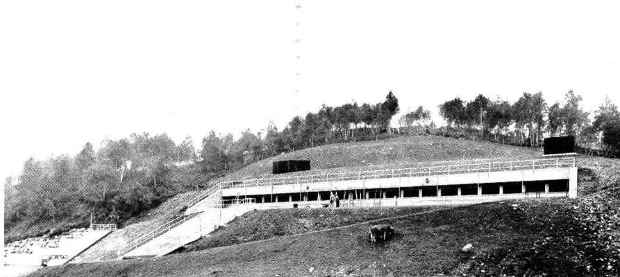
Fig. 1 Ansicht der Sendeanlage mit der in der Galerie untergebrachten Luftfassung zur Kühlung und dem 250 m hohen, mehrfach abgespannten Sendemast
