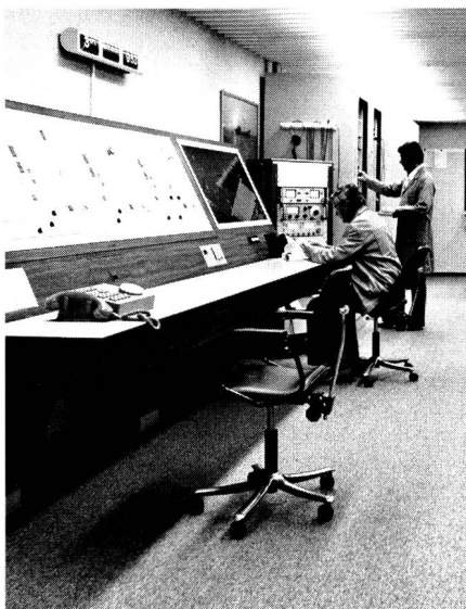
Fig. 2 Überwachungs- und Kommandopult (vorne) und minicomputerbediente Steueranlage (hinten)
