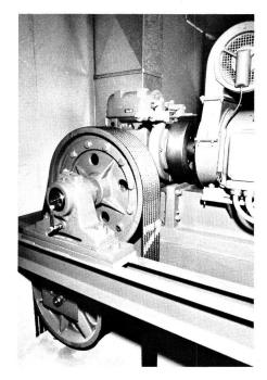
Fig. 2 Antrieb eines Personenaufzugs
