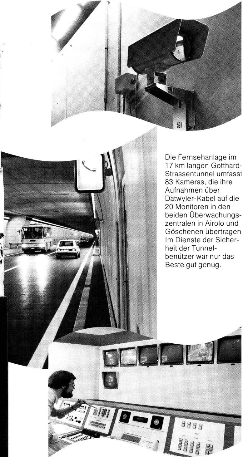
Die Fernsehanlage im 17 km langen Gotthard-Strassentunnel umfasst 83 Kameras, die ihre Aufnahmen über Dätwyler-Kabel auf die 20 Monitoren in den beiden Überwachungszentralen in Airolo und Göschenen übertragen. Im Dienste der Sicherheit der Tunnelbenutzer war nur das Beste gut genug.
