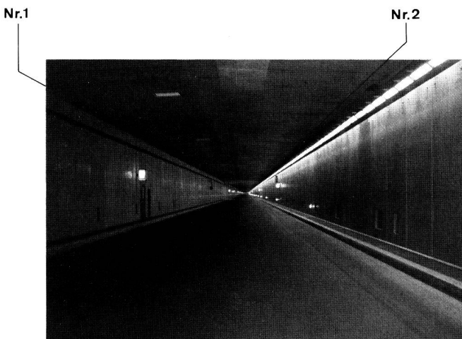
Fig. 2 Blick in den Tunnel mit den strahlenden HF-Kabeln — Vue du tunnel avec les câbles HF rayonnants
