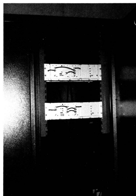
Fig. 5 Anordnung der Breitbandverstärker in einem Tunnelquerschlag — Disposition des amplificateurs à large bande dans une niche latérale du tunnel
