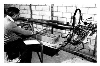
Kontrollmessungen vor dem Einbau der Zwischenverstärker
