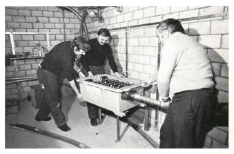
Fig. 16 Einfügen eines Zwischenverstärkers
