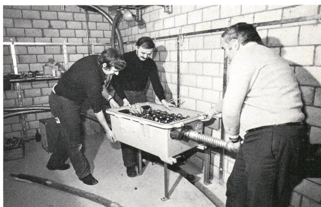
Fig. 16 Einfügen eines Zwischenverstärkers
