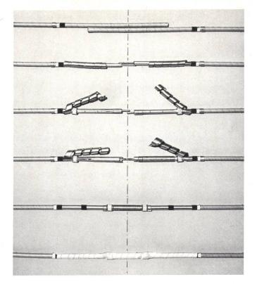
stet die beste Zugänglichkeit im Störungsfalle. Die Spleissung ist mit einer zweiteiligen Bleimuffe gegen das Eindringen von Feuchtigkeit und zusätzlich gegen mechanische Beschädigungen mit einem auf den Konsolen befestigten Deckblech geschützt (Fig. 8).
