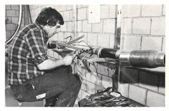
Fig. 8 Spleissen eines Koaxialkabels
