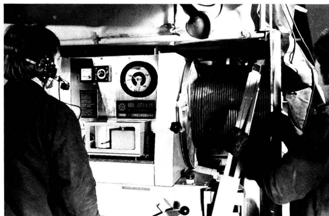
Fig. 5 Unter ständiger telefonischer Verbindung mit den Überwachungs- personen auf den Arbeitspodesten und beim Kabelhaspel verfolgt der Mann an der Kabelzugwinde aufmerksam das Zugdiagramm — Il ma- novratore dell'argano controlla il diagramma di tiro, costantemente in contatto telefonico con gli addetti alla piattaforma di lavoro e all'aspo
