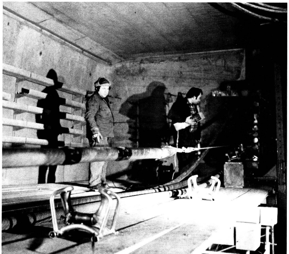
Fig. 4 Ein Koaxialkabel kurz vor dem Eintritt in den Asbestzement-Rohrzug mit 100 mm Innendurchmesser. Kabeldurchmesser: 76,3 mm; Kabelgewicht: 8,5 kg/m. Für die telefonische Verständigung war wegen des Baustellenlärms die Verwendung von Kopfsprechgarnituren unumgänglich — Cavo coassiale pronto per l'introduzione nel tubo di cemento-amianto del diametro interno di 100 mm. Diametro del cavo: 76,3 mm; peso: 8,5 kg/m. A causa dei rumori di cantiere è stato necessario fare uso di cuffie per le comunicazioni telefoniche di lavoro
