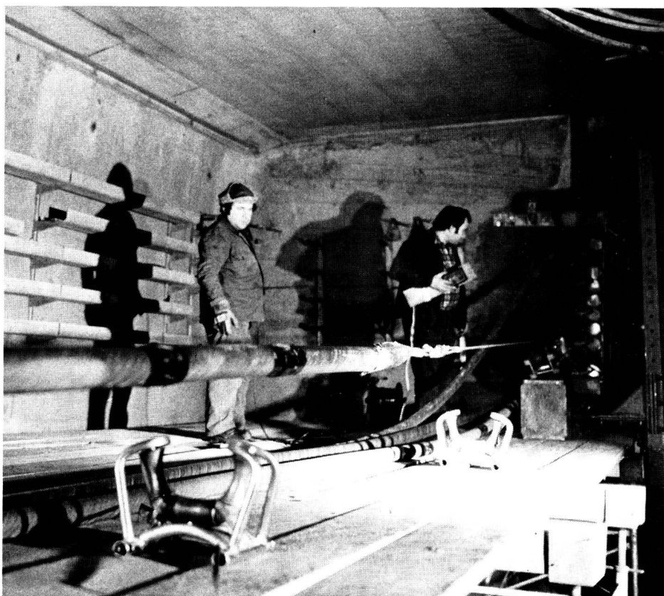
Fig. 4 Ein Koaxialkabel kurz vor dem Eintritt in den Asbestzement-Rohrzug mit 100 mm Innendurchmesser. Kabeldurchmesser: 76,3 mm; Kabelgewicht: 8,5 kg/m. Für die telefonische Verständigung war we- gen des Baustellenlärms die Verwen- dung von Kopfsprechgarnituren unum- gänglich — Cavo coassiale pronto per l'introduzione nel tubo di cemento- amianto del diametro interno di 100 mm. Diametro del cavo: 76,3 mm; peso: 8,5 kg/m. A causa dei rumori di cantiere è stato necessario fare uso di cuffie per le comunicazioni telefoniche di lavoro
