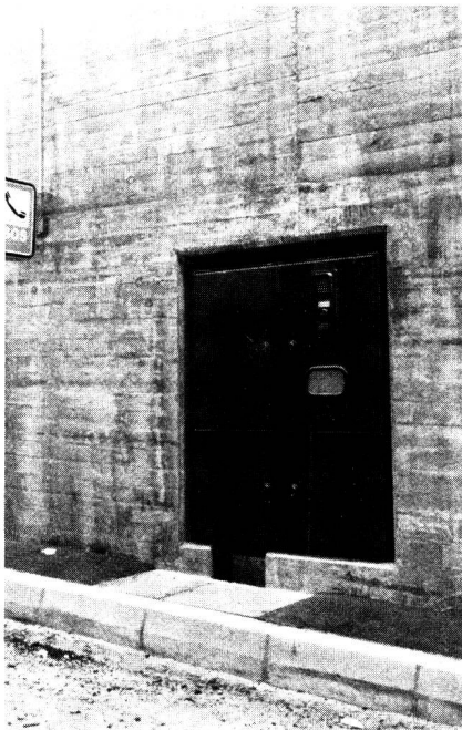
Fig. 1 SOS-Kasten mit Gegensprechanlage und Handfeuerlöschern — Poste SOS avec installation d'interphone et extincteurs à main
