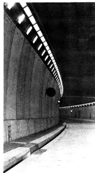
Fig. 2 14 000 solcher Leuchten sorgen für die richtige Ausleuchtung des Tunnels — 14 000 lampes de ce genre assurent l'éclairage judicieux du tunnel
