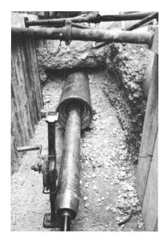
Fig. 6 Rammapparat im Einsatz
