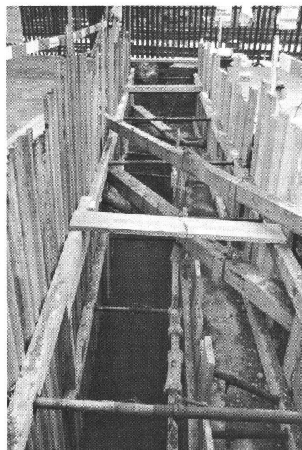
Fig. 3 Anordnung im Bereich der Gleise bei der Unter- querungsmethode nach dem «offenen Graben»
