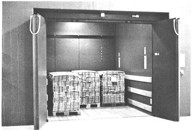
Fig. 16 Aufzugskabine
