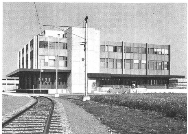
Fig. 1 Materialdienstgebäude im «Eichfeld» in Jona
