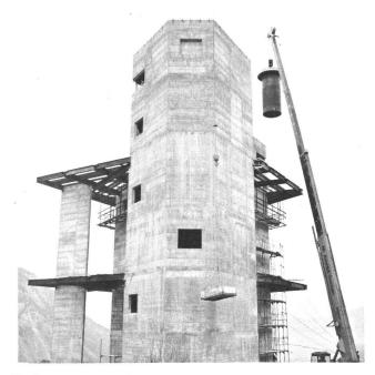
Fig. 2 Montage du premier élément du pylône
