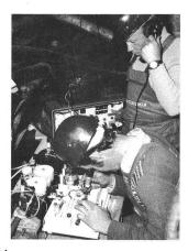
Fig. 4 Spleissen von Lichtleitfasern im Kabelschacht
