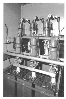
Fig. 1 Regelbarer Hochspannungsgleichrichter, mit 6 Thyratrons bestückt
