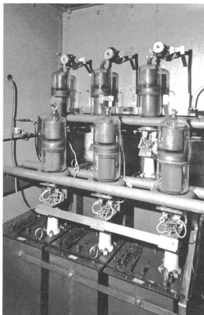
Fig. 1 Regelbarer Hochspannungsgleichrichter, mit 6 Thyratrons bestückt
