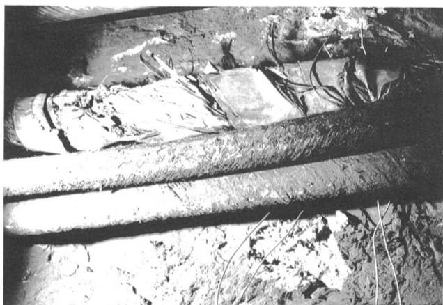
Fig. 2 Kabelbeschädigung im Bahntunnel — Danneggiamento dei cavi nella galleria ferroviaria
