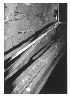
Fig. 1 Kanalbeschädigung im Gotthardtunnel der Schweizerischen Bundesbahnen – Danneggiamento dei canali nella galleria ferroviaria del San Gottardo
