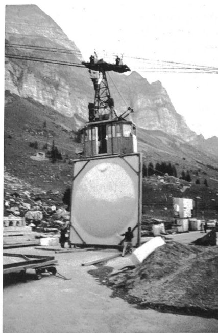
Fig. 4 Sondertransport von Kavernenabdeckungen nach der Höhenstation Sântis — Transport spécial de panneaux de protection d'antennes pour la station du Sântis
