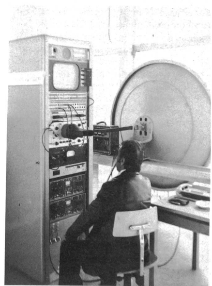
Fig. 3 Anlage für die Einspeisung von Fernsehprogrammen mit mobilem Richtstrahl-Link auf La Dôle
