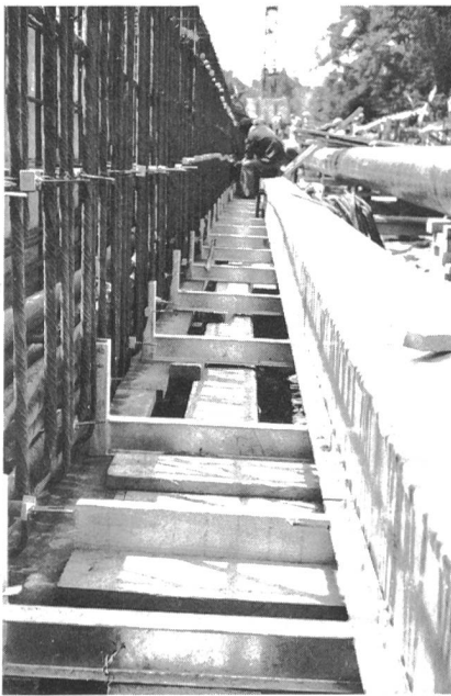
Fig. 7 Die Kabel sind endgültig in den Blechkanal eingelegt. Die Verankerungen der Trägerelemente werden in die Armierung des Brückenlängsträgers einbezogen
