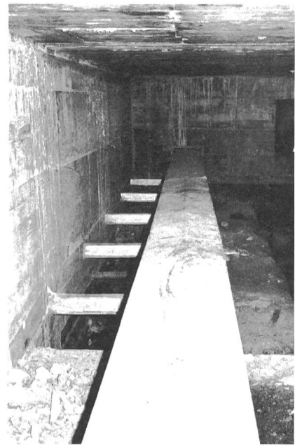
Fig. 9 Der Blechkanal im endgültigen Zustand unter der Fahrbahnplatte
