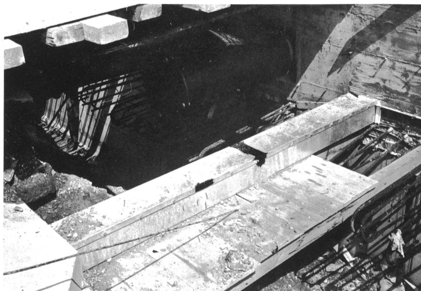
Fig. 5 Blechkanal über dem Aushub für die Personenunterführung. Die Kabel sind in die Stahlkanäle eingelegt und die Deckel darauf verschraubt. Links unten ist der Trichter zum Einstiegsschacht, rechts die Rückwand des Brückenwiderlagers mit den Anschlusseisen in die Decke der Personenunterführung erkennbar. Sämtliche Fugen des Stahlkanals wurden vor dem Betonieren der Decke mit Teerband wasserdicht überklebt
