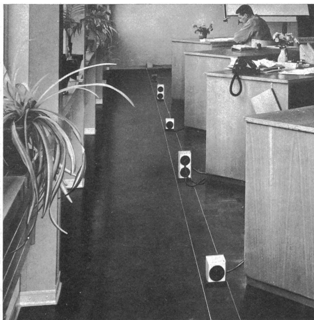
Fig. 7 Canale a livello del pavimento (con coperchio) e zoccoli di raccordo
