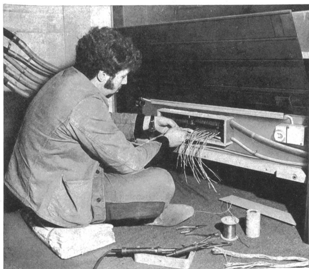
Fig. 3 Montatore dei telefoni che connette un distributore intermedio a parapetto
