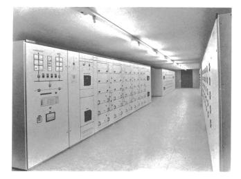
Fig. 5 Schaltanlage 380/220 V
