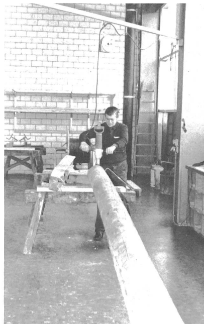
Fig. 10 Montage von Kabelstangen
