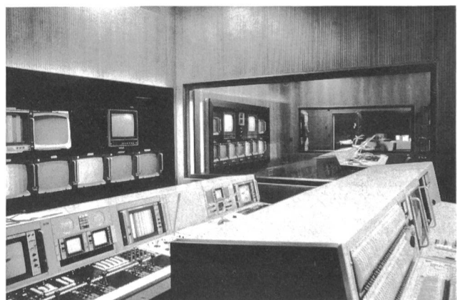
Fig. 16 Technischer Kontrollraum Studio 1. Links vorne technischer Kontrollplatz, rechts vorne Lichtregiepult; im Hintergrund die Räume der Bild- und Tonregie — Sala controllo tecnico dello studio 1. A sinistra davanti il banco controllo tecnico, a destra davanti la regia luci; sullo sfondo i locali per le regie video e audio.
