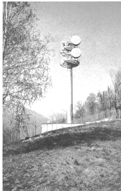
Fig. 20 Richtstrahlstation Gaggio — Stazione ponti radio Gaggio
