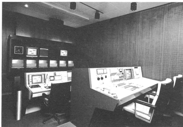
Fig. 17 Technischer Kontrollraum des Aktualitätenstudios. Vorne rechts das Lichtregiepult, links darunter Bild- und Endkontrollplatz — Sala controllo tecnico dello studio per l'attualità. Davanti a destra il banco regia luci, a sinistra il banco controllo video e controllo finale
