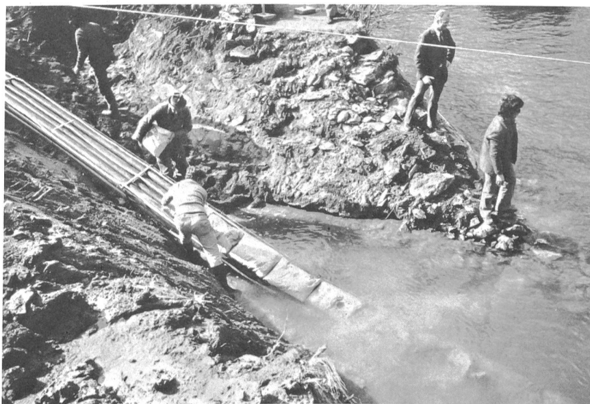
Fig. 4 Belastung des Rohrblocks mit Zementsäcken
