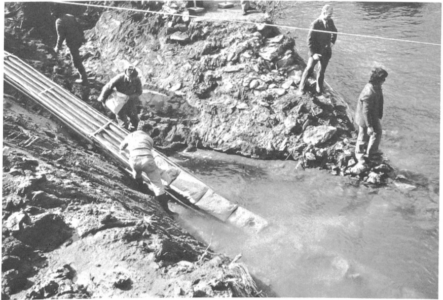
Fig. 4 Belastung des Rohrblockes mit Zementsäcken
