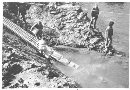
Fig. 4 Belastung des Rohrblocks mit Zementsäcken
