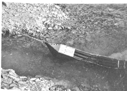
Fig. 3 Rohrschlitten beim Ausfahren
