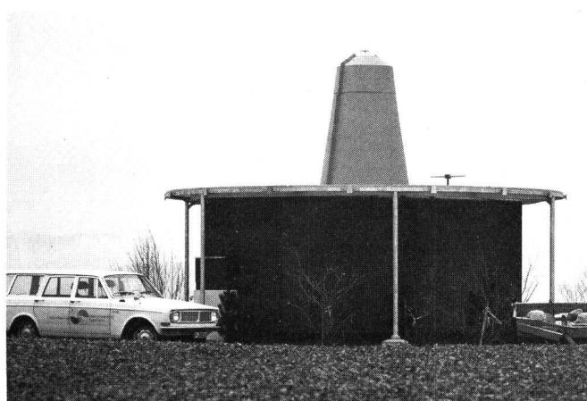
UKW-Drehfunkfeuer der Flugsicherung
