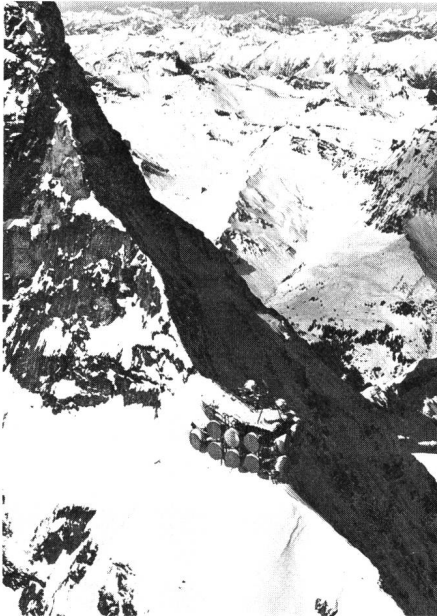
Richtstrahl-Relaisstation auf dem Jungfrau-Grat – Brücke zwischen Nord und Süd über den Alpenkamm für Telefonie und Fernsehen
