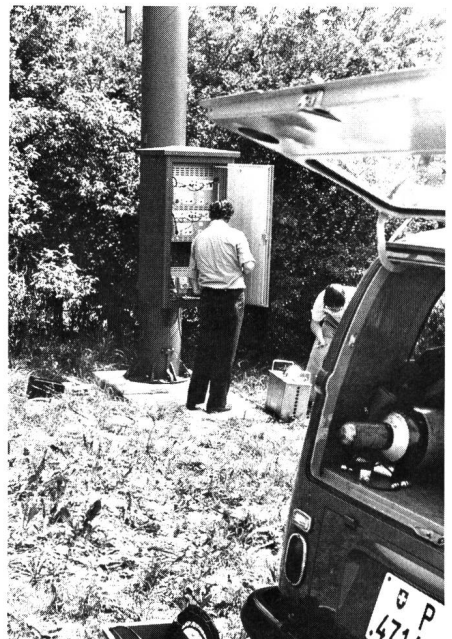
Messarbeiten an einem TV-Kleinstumsetzer Travaux de mesure sur un micro-réémetteur de télévision Measurements on a TV miniature transposer
