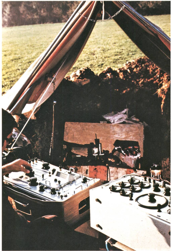
▲ Messungen im Felde an einem Kabel Mesures d'un câble en campagne Field measurements on a cable
