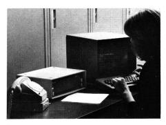
Fig. 3 Kundeninstallation mit Telefonapparat mit Data-Umschalter, PTT-Modem und Datensichtgerät
