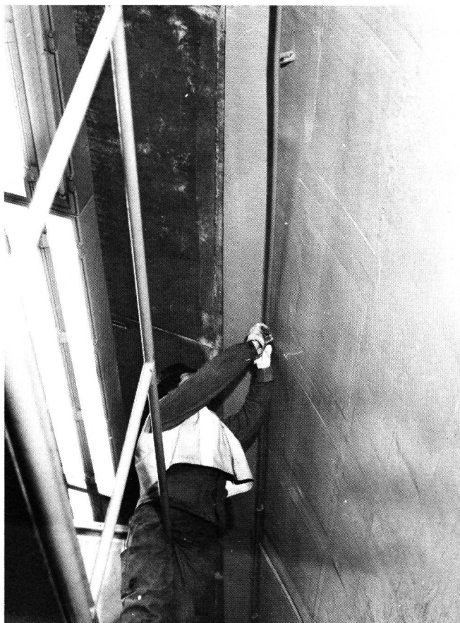
Fig. 15 Verlegung eines strahlenden Kabels in einem Strassentunnel
