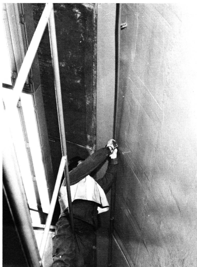
Fig. 15 Verlegung eines strahlenden Kabels in einem Strassentunnel
