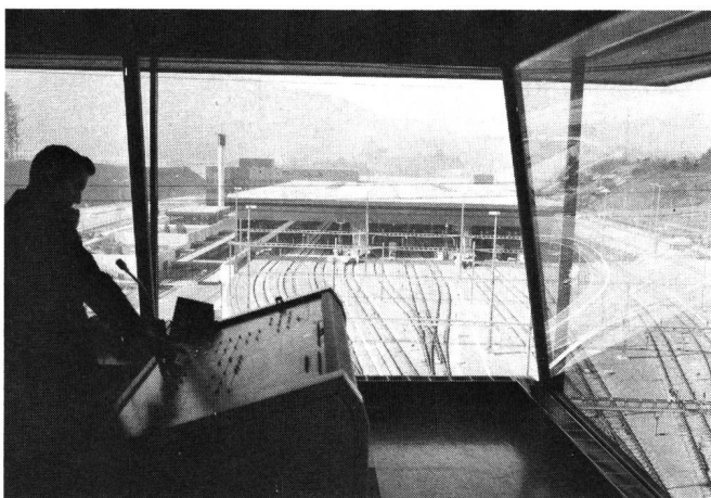
Fig. 40 Kommandopult für den Postbahnhof im Stellwerk der SBB – Pupitre de commande pour la gare postale au poste d'aiguil- lage des CFF
