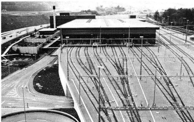
Fig. 39 Blick über den Postbahnhof vom Stellwerk aus – Vue de la gare postale depuis le poste d'aiguillage
