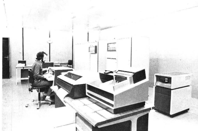
Fig. 27 Gesamtansicht des Rechnerraumes – Vue générale du local du processeur
