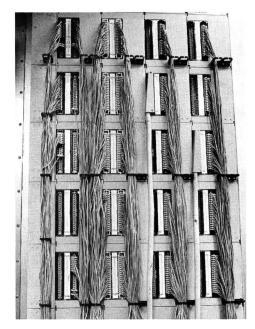
Fig. 6 Hauptverteiler
