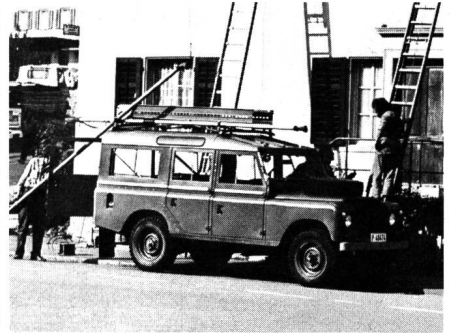
Telefonleitungsmontage oder Freileitungsbau
