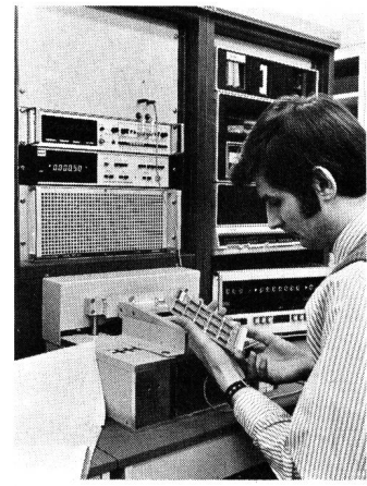
Fig. 5 Pegamat, universelles Prüfsystem für elektronische Leiterplatten und Geräte
