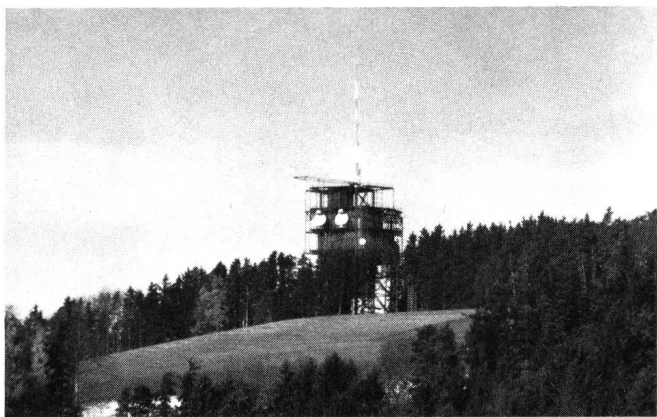
Fig. 2 Die Mehrzweckanlage von der Strasse Oberulmiz-Kühlewil aus gesehen
