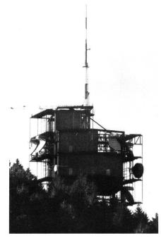
Fig. 6 Betriebsräume, Antennenträger und Richtstrahlantennen
