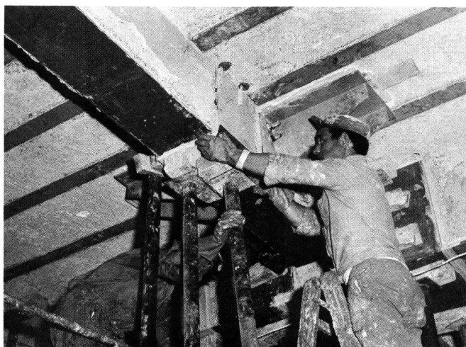
Fig. 2 Anbringen der Verstärkung
