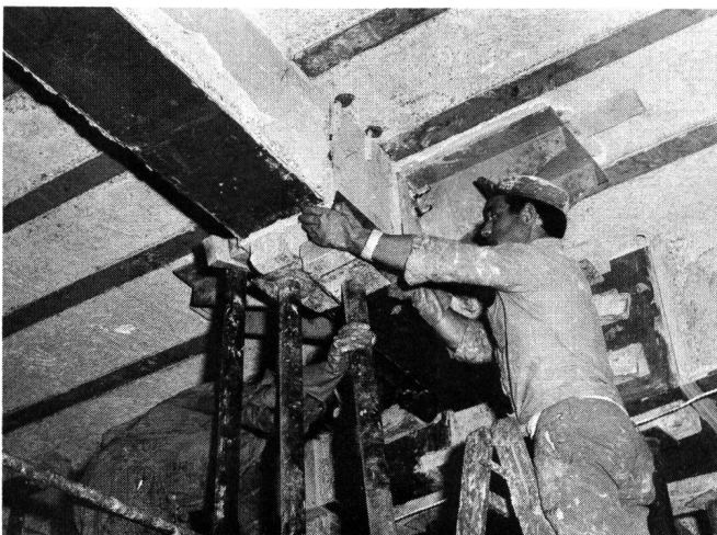
Fig. 2 Anbringen der Verstärkung
