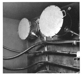
Fig. 6 Blick in einen unterirdischen Zwischenverstärkerschacht. Für die beiden Übertragungseinrichtungen werden in Zweikabelbetrieb getrennte Kasten verwendet
