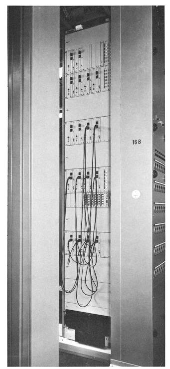
Fig. 5 Gestell mit den Leitungsendstellen. Pro Baugruppenträger sind 4 Leitungsendstellen vorhanden. Die auf der Fotografie ersichtlichen Kabel wurden zu Messzwecken eingesetzt
