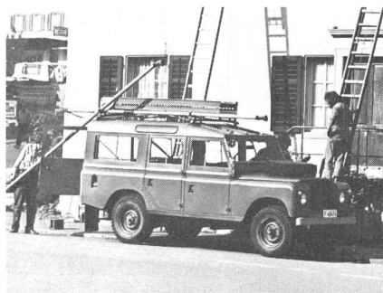
Telefonleitungs- oder Freileitungsbau
