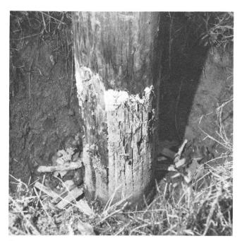
Fig. 7 Teilweise vom Pilz zerstörter Mast im Stangengarten
