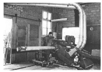
Fig. 5 Entrinden eines Fichtenstammes mit der Schälmaschine
