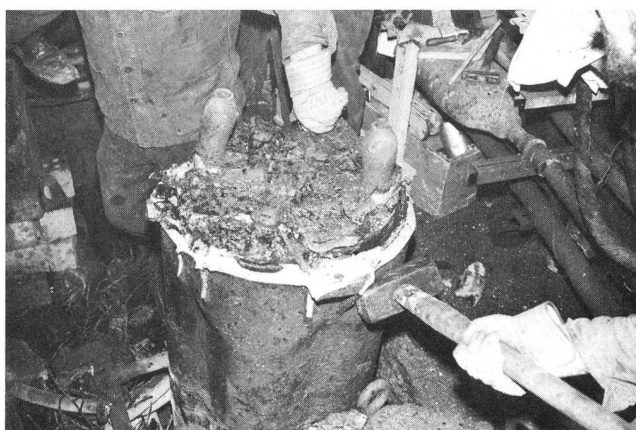
Fig. 6 Demolizione dei residui con la mazza
