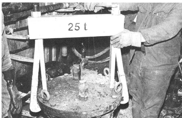
Fig. 3 Smontaggio dei vecchi contenitori Pupin: messa in opera del giogo a ganci
