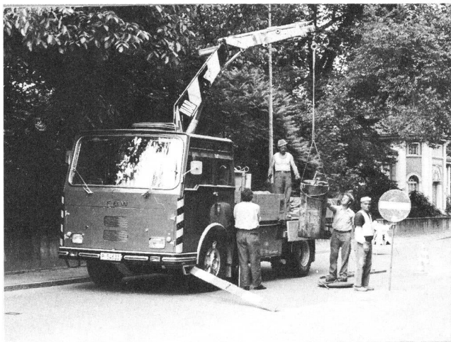
Fig. 8 Carico dei vecchi contenitori Pupin
