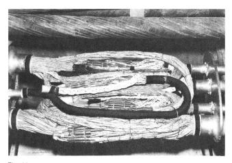
Fig. 14 Vista interna di un giunto Pupin
