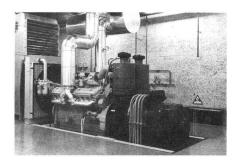
Fig. 2 Diesel-Notstromgruppe einer Regionalstation
