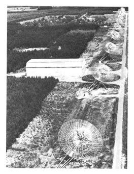
Fig. 8 25-m-Antennenspiegel des holländischen Synthese-Radio-Interferometers Westerbork
