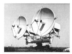
Fig. 7 Antennen für die Vorversuche mit dem OTS-Transponder (14/11 GHz) zwischen Interlaken und dem Jungfraujoch
