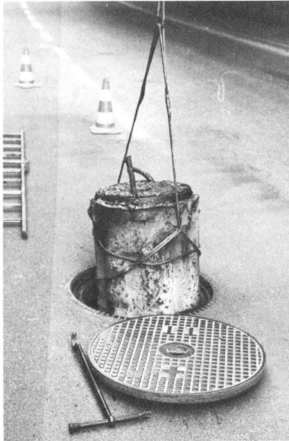
Fig. 7 Ausbau eines mit der Zertrümmerungsvorrichtung vorbereiteten Pupintopfes – Extraction d'un caisson Pupin dont le bord est détruit
