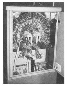
Fig. 4 Kabelverteilkasten mit kreisförmiger Aufteilung der Adern, die somit alle gleich lang vorbereitet und sehr einfach aufgeschaltet werden können (Pever)
