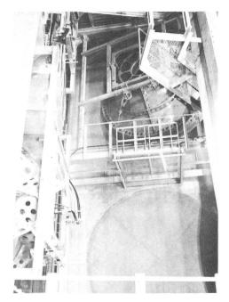
Fig. 11 Teilansicht einer Richtstrahlkaverne mit einem belegten und einem freien Strahlungsfenster von  $6\times 6~\text{m}$
