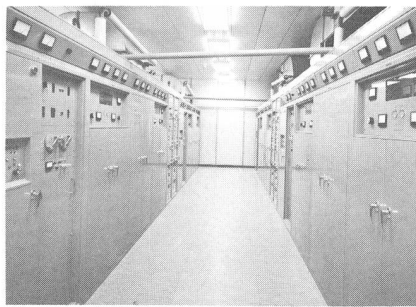
Fig. 3 Teilansicht der Senderanlagen im Neubau mit den Sendern für die zweite und dritte TV-Senderkette (UHF)
