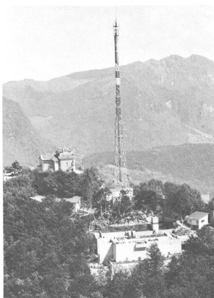
Fig. 1 Gipfelpartie des San Salvatore. Im Vordergrund der Neubau der PTT-Mehrzweckanlage, rechts davon das 1958 erstellte Sendegeäude (das nun einer andern Verwendung zugeführt wird), über dem Neubau der 84 m hohe Antennenturm und darunter das (abbruchgeweihte) Provisorium
