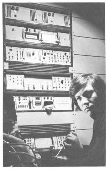
Fig. 1 Terminal pour le système numérique STC de 120 Mbit/s installé sur une liaison de télécommunications interurbaine dans le sud de l'An-
