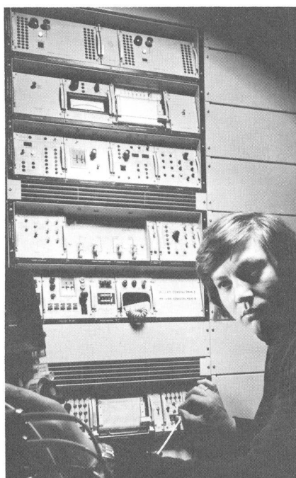
Fig. 1 Terminal pour le système numérique STC de 120 Mbit/s installé sur une liaison de télécommunications interurbaine dans le sud de l'Angleterre.
