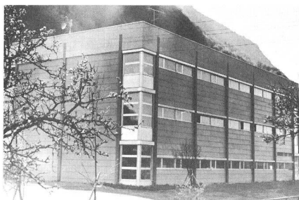
Fig. 1 Südwestansicht des neuen Fernmeldezentrams Niederurnen.
