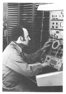
Fig. 2 Abgleichen und Einmessen von Leitungen
